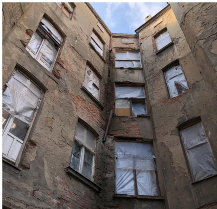
Rys. 6. przykłady uszkodzeń rynien i rur spustowych. Źródło: archiwum BZB Projekt.
